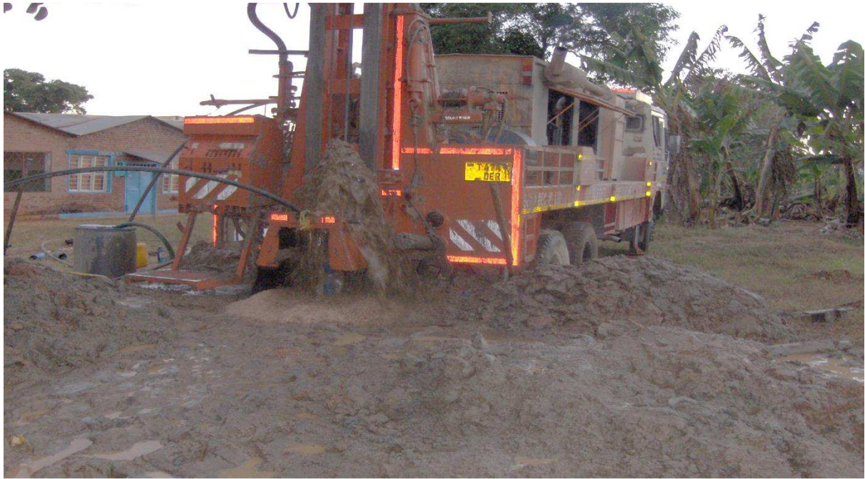
Die professionelle Arbeit für den tiefen Brunnenschlag hat begonnen
